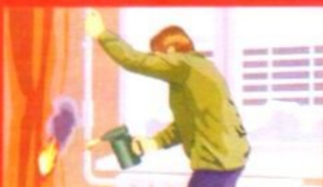
Отогревание замерзших труб паяльными лампами и факелами
